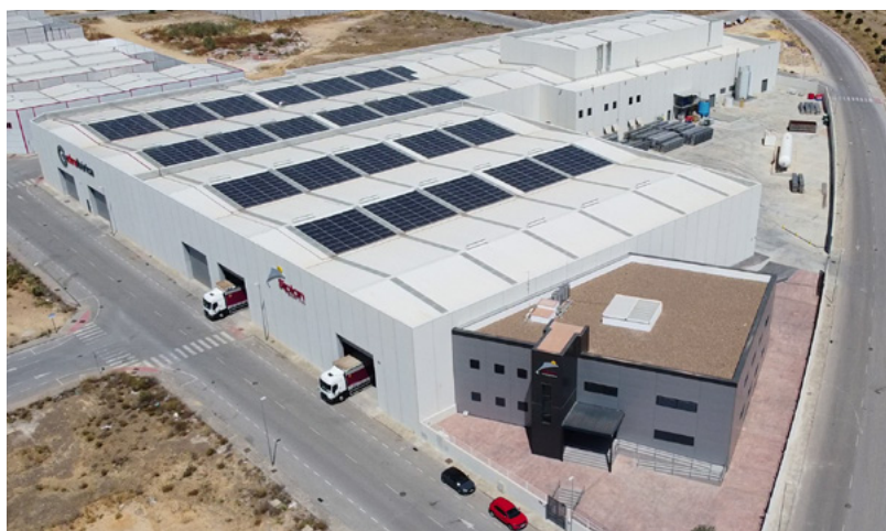
Centro de Fabricación / Manufacturing Center Mairena del Alcor
